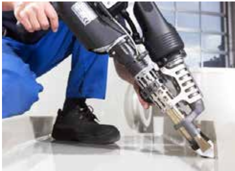
Figura 23. Soldadura por extrusión
