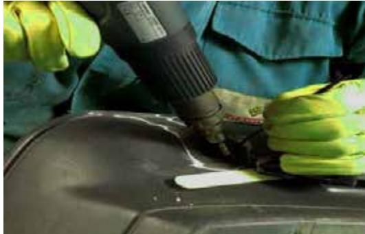
Figura 21. Reparación de pieza plástica mediante soldadura de aire caliente
