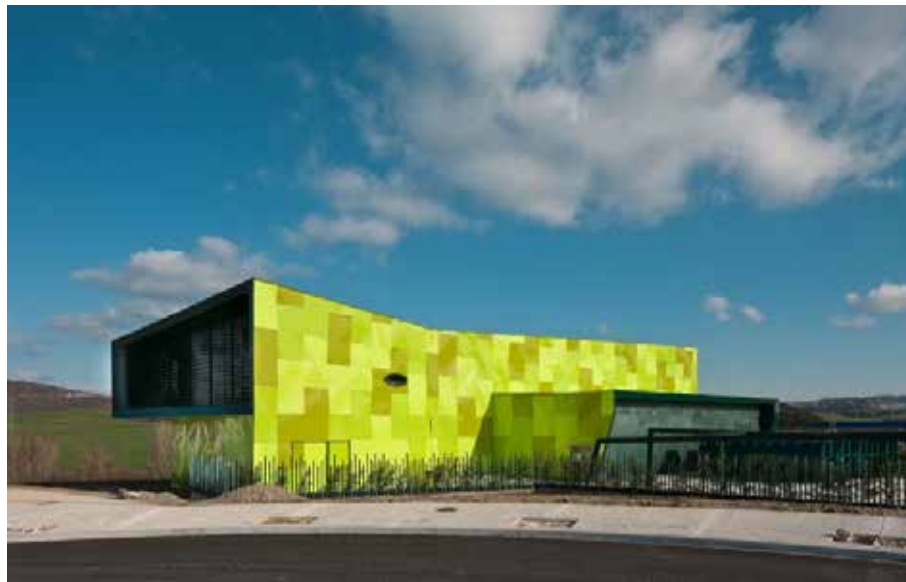
Figura 2. Central de Recogida de Residuos Sólidos Urbanos, Navarre-España. Fuentes: http://www.plataformaarquitectura.cl/cl/626374/central-de-recogida-de-residuos-solidos-urbanos-vaillo-and-irigaray-galar/512890aab3fc4b11a70047d5 (2014)
