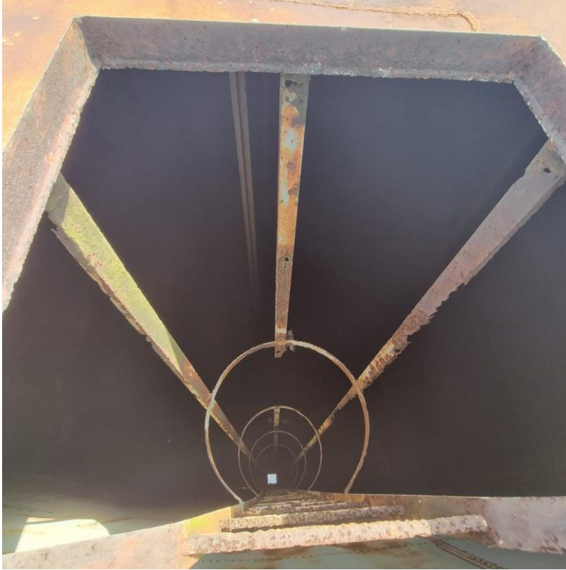
Figura 5: Foto del Interior del Tanque de Agua.
