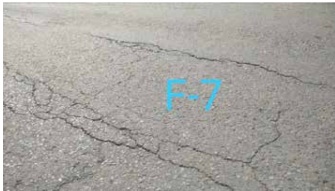
Figura 36: Hundimiento en la calle Rondón.
