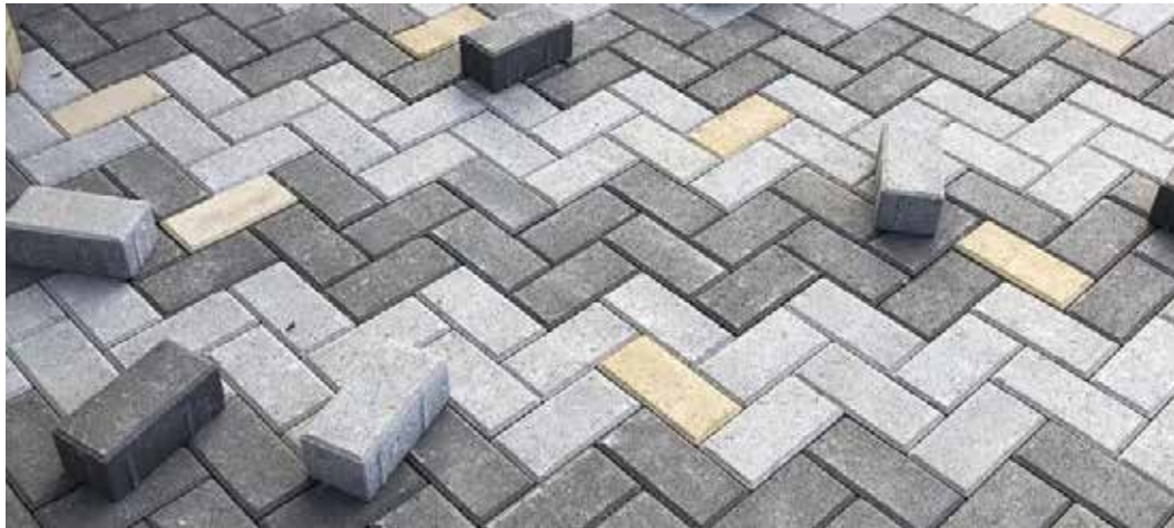
Figura 22: Adoquín colocado a 45 grados.
