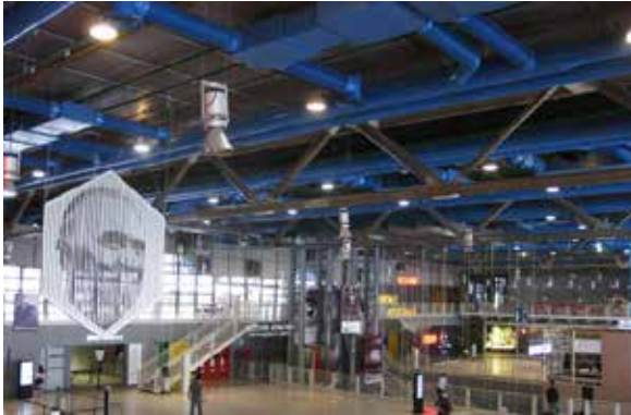
Figura 70. Ejemplo de Tuberías y Estructura de techo. Fuente: https://www.blogger.com/blogin.g?blogspotURL=http://www.gusplanet.net/2011/05/centro-pompidou-de-paris.html&bpli=1&pli=1 (2019)
