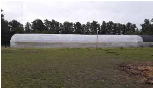
Figura 3. Fachada Lateral. Proyecto aQüidar.
