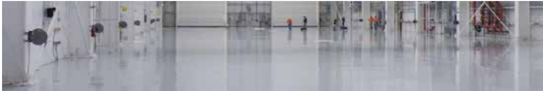
Figura 69. Ejemplo de pisos con Resina Epoxica. Fuente:
