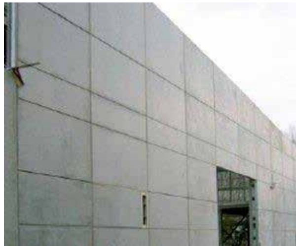
Figura 15: Concreto Armado. Fuente: http://lineaprevencion.com (2018)
