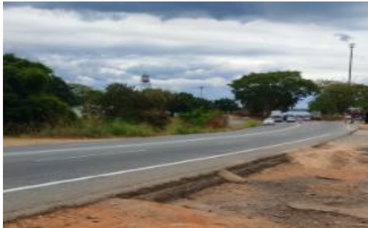
Figura 22: Exudación de asfalto, deterioro superficial, desnivel de la calzada hombrillo, corrugaciones y ahuellamiento
