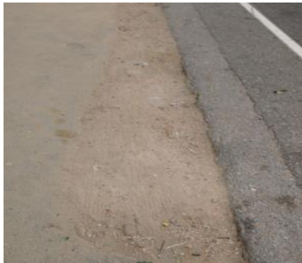
Figura 22: Exudación de asfalto, deterioro superficial, desnivel de la calzada hombrillo, corrugaciones y ahuellamiento
