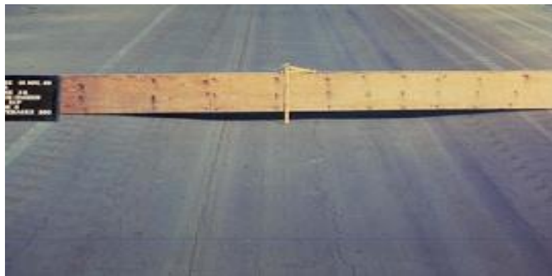
Figura 11. Ahuellamiento
