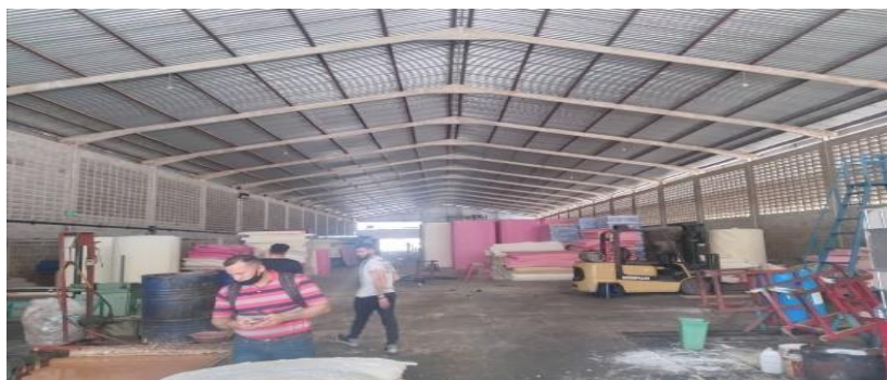
Figura 9. Vista trasera del galpón o área productiva de la empresa Sueños Real, C.A
