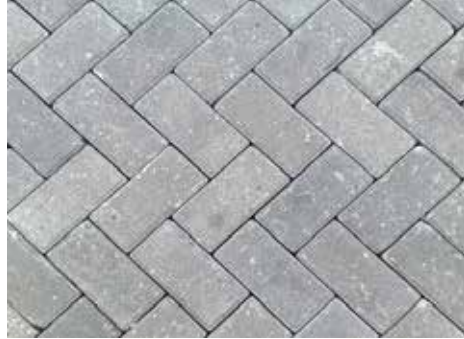
Piso de concreto espina de pez. Auditorio y Biblioteca de la Ciudad de los Muchachos Madre Teresa de Calcuta (2018)
