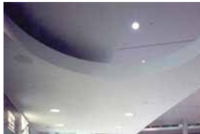
Cielo raso de drywall. Auditorio y Biblioteca de la Ciudad de los Muchachos Madre Teresa de Calcuta (2018)
