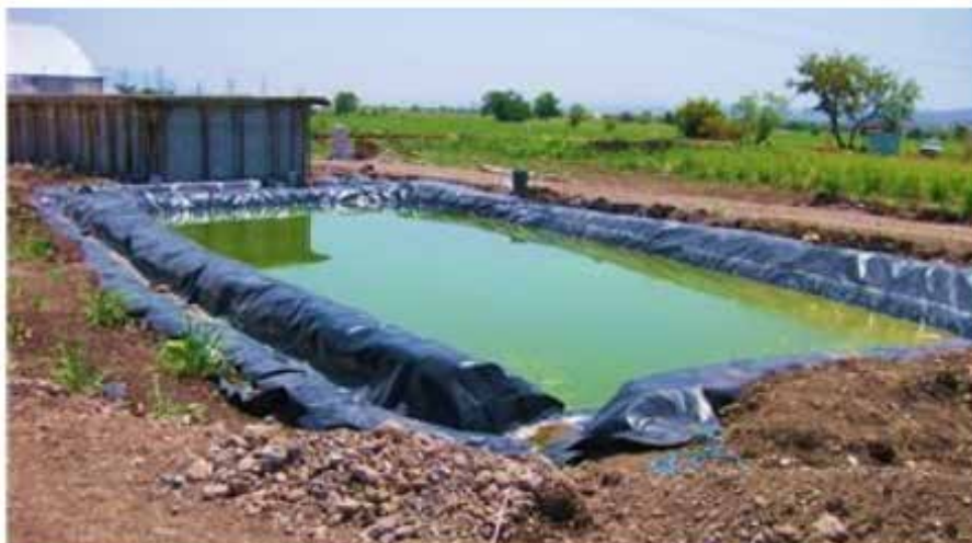
Figura 34 Ejemplo de estanque con geomembrana
