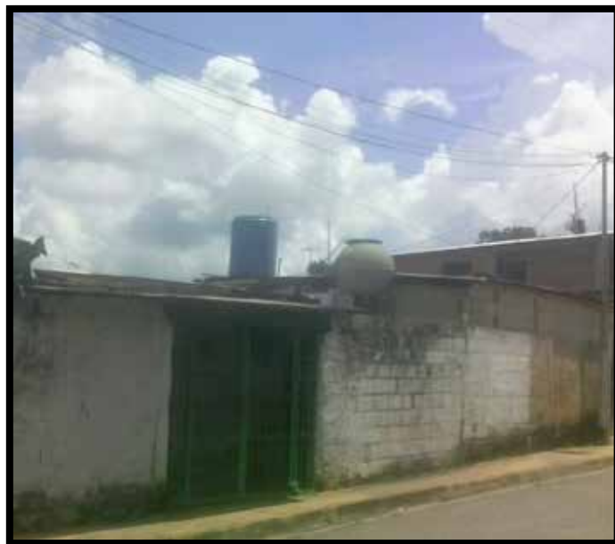
Tanque de almacenamiento elevado de una casa del sector el Cementerio.
