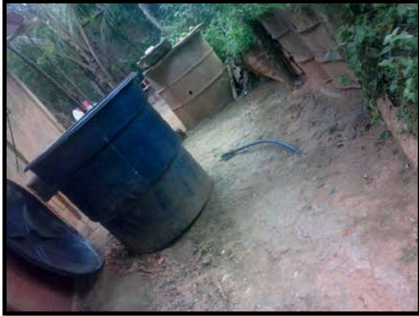
Tanque de almacenamiento y tubería (sin agua) de una casa del sector el Cementerio.
