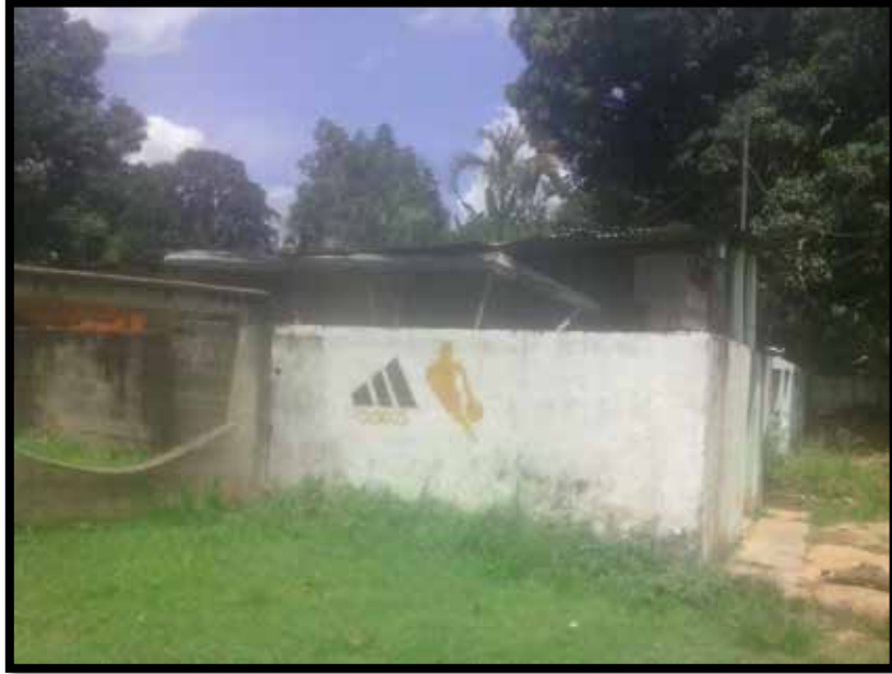
Canal improvisado con láminas de zinc para recoger agua de lluvia en el sector el Cementerio.
