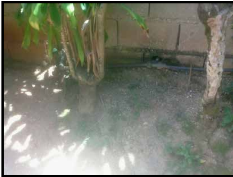
Tubería de dos pulgadas (2") ubicada en el sector el Cementerio.
