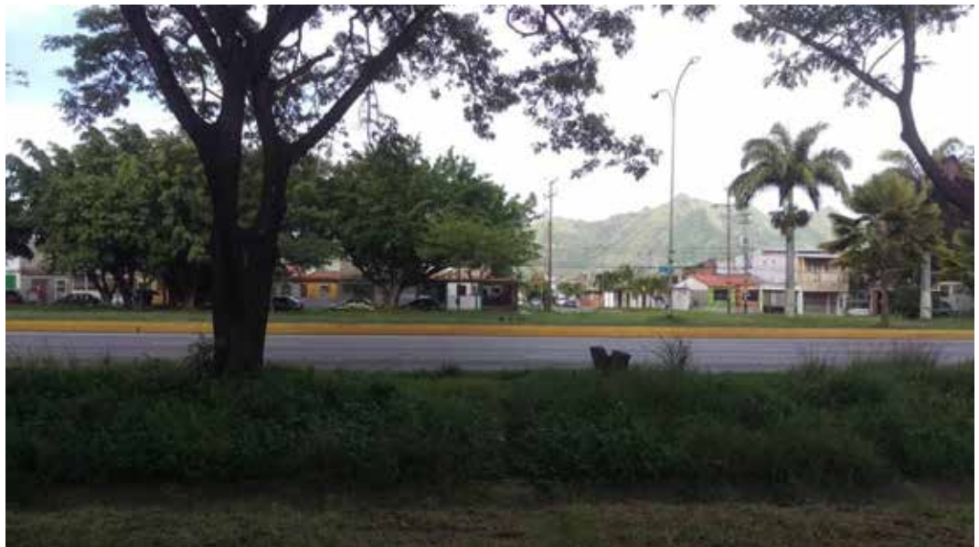
Figura 13. Vista in situ donde se desea realizar el proyecto sentido Residencias Tulipan - Euromax. Fuente: Araya, J (2018).
