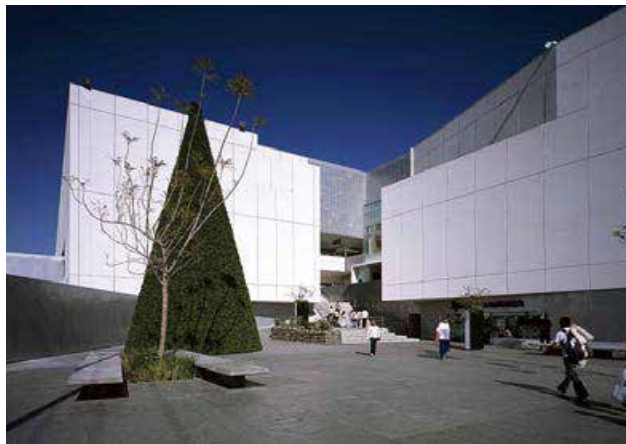
Figura 6. Acceso Sur. Fuente: http://es.wikiarquitectura.com/index.php/Terminal_Multimodal_Azteca (2012)
