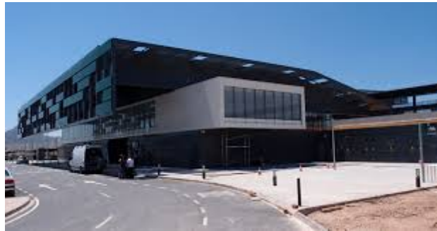
Figura 2. Detalle cubierta. Fuente http://www.plataformaarquitectura.cl/cl/02-330712/la-estacion-de-alta-velocidad-de-villena-cootar/52e71f3be8e44e081d00025a (2013)
