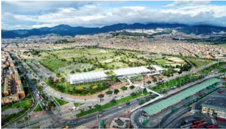
Figura 5. Vista aérea. Fuente: https://www.archdaily.co/co/879423/propuesta-arquitectura-disenara-nuevo-centro-recreativo-del-parque-metropolitano-el-tunal-en-bogota (2017)
