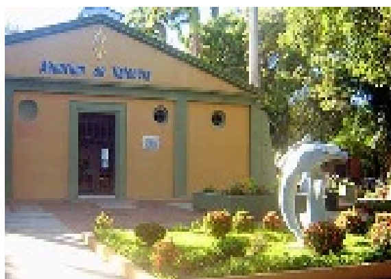
Figura 17. Aquarium de Valencia, vista externa.
