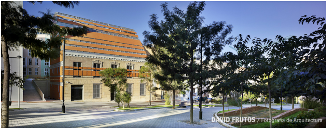
Figura 4: Vista panorámica de la fachada principal de la casa del estudiante Fuente: David Frutos fotografía de arquitectura (2009)
