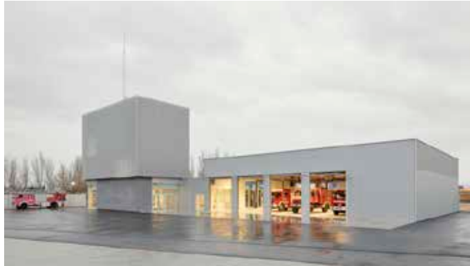
Figura 5. Parque de Bomberos de n°4. Fuente: https://www.plataformaarquitectura.cl/cl/943862/parque-de-bomberos-no-4-idom?ad_medium=gallery (2020)
