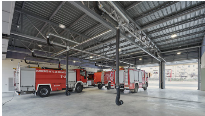
Figura 6. Sala de Máquinas Parque de Bomberos de n°4. Fuente: https://www.plataformaarquitectura.cl/cl/943862/parque-de-bomberos-no-4-idom?ad_medium=gallery (2020)
