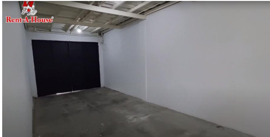
Figura 8: Depósito planta baja ángulo 2 del establecimiento propuesto
