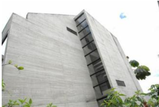
Figura 29. Acabado Concreto Arquitectónico. (2018).
