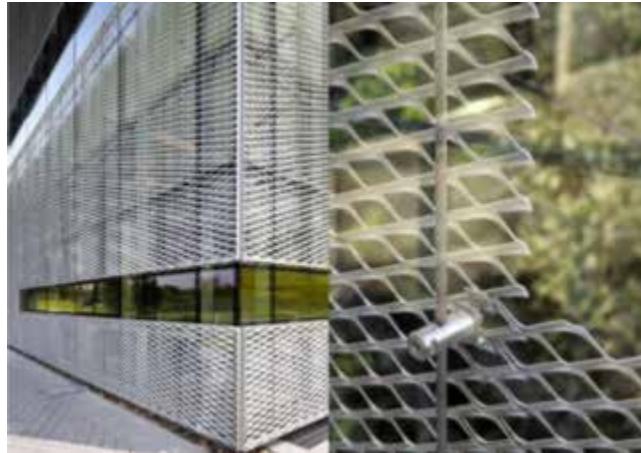
Figura 31. Acabado Panel Metálico Perforado. (2018).
