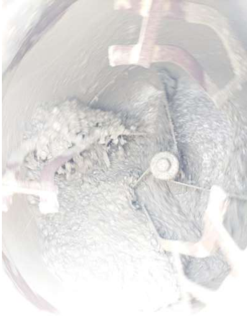
Figura 20: Mezcla de concreto en trompo.
