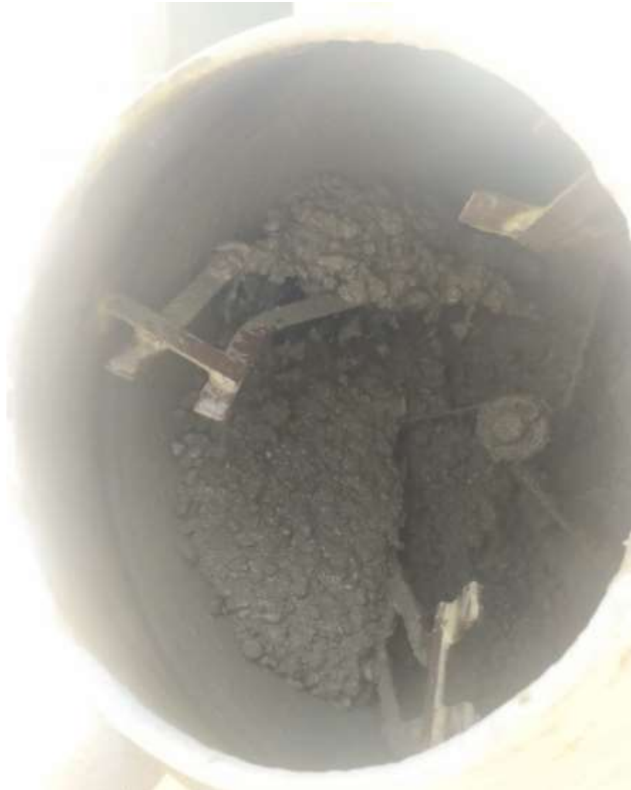
Figura 19: Mezcla de concreto en trompo.
