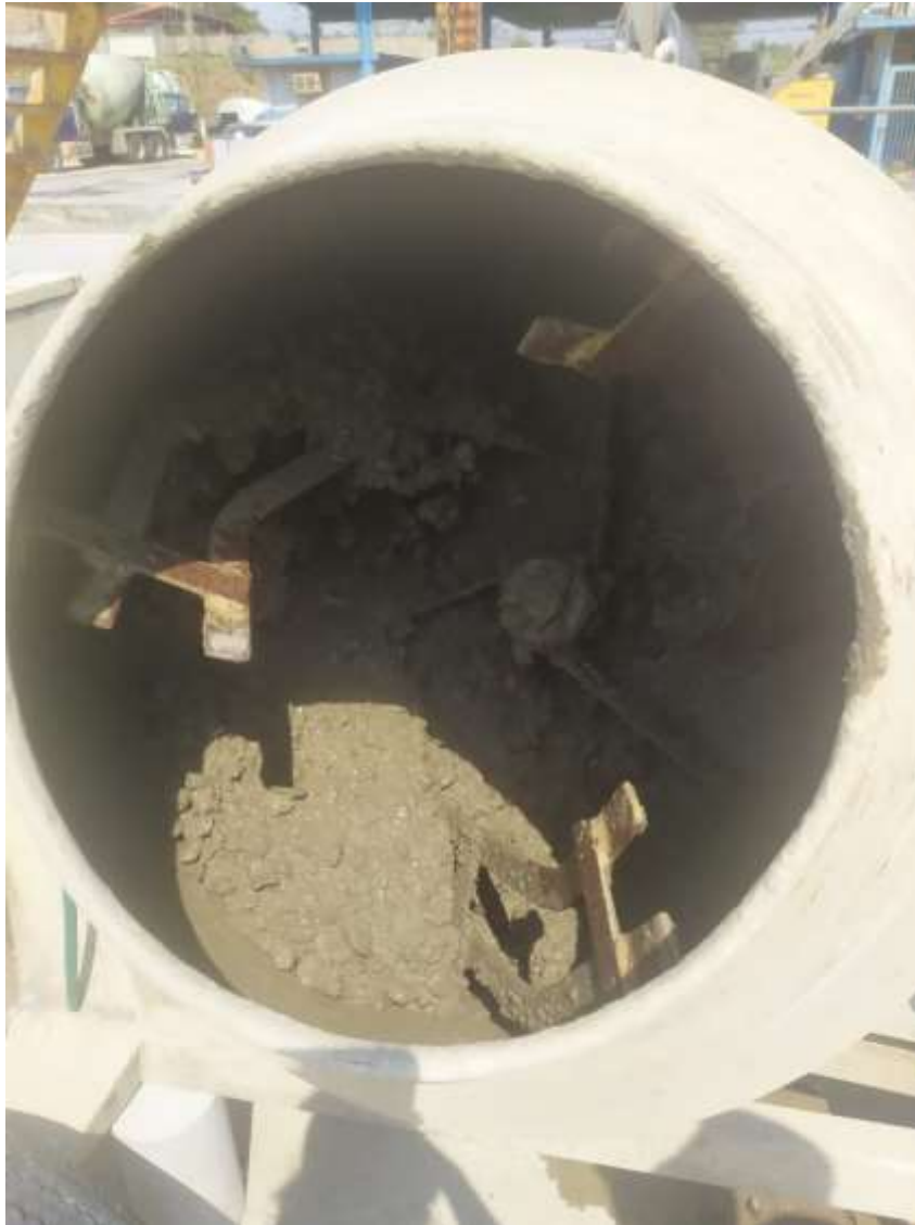
Figura 21: Mezcla de concreto en trompo.
