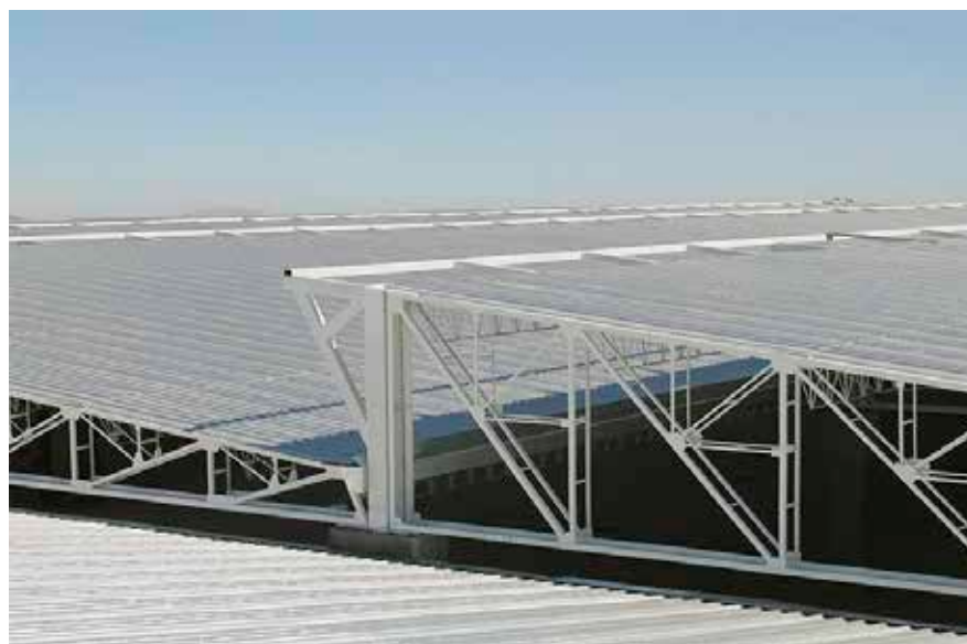
Figura 26: Techos de láminas Termoacusticas.
