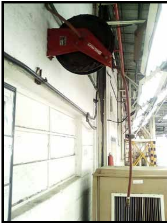
Figura 27: Carrete tipo rache propuesto para la estación 31.
