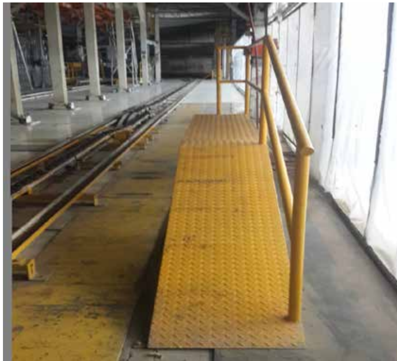
Rampa lado Derecho estación Lat-31
