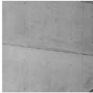
Figura 31: Concreto Armado Pulido (2018)
