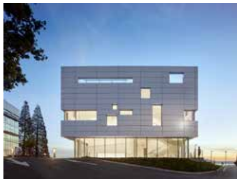
Figura 3. Fachada lateral izquierda Centro de investigación de energía solar Chu Hall.
