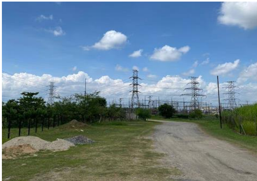
Figura 19. Vía de acceso
