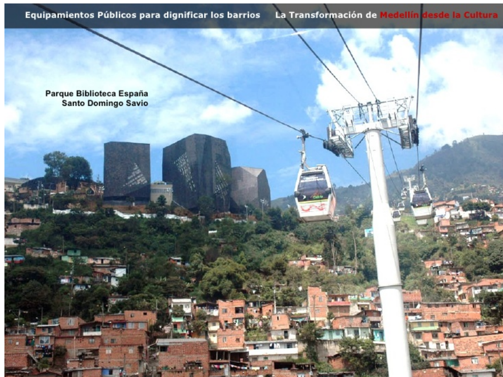
. Parque Biblioteca España, con el metro cable.
