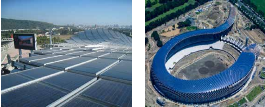
Figura 52. Estadio solar de Fútbol Kaouhsiung (Taiwán).
