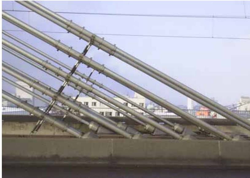
Figura 28. Amortiguadores en los cables en el puente atirantado de Mannheim (Alemania).
