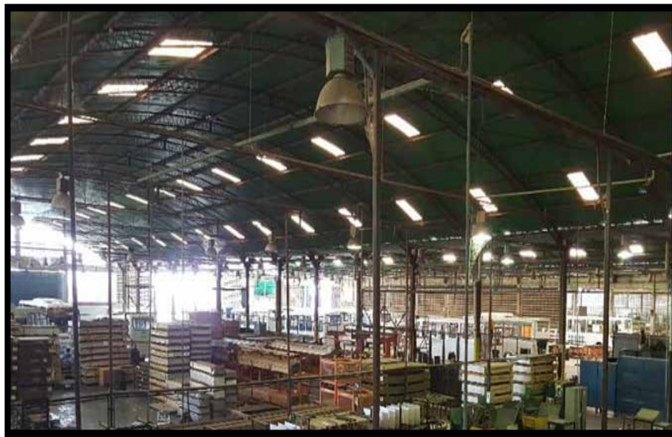
Figura 33. Área donde se almacena el material: piezas metálicas y materia prima
