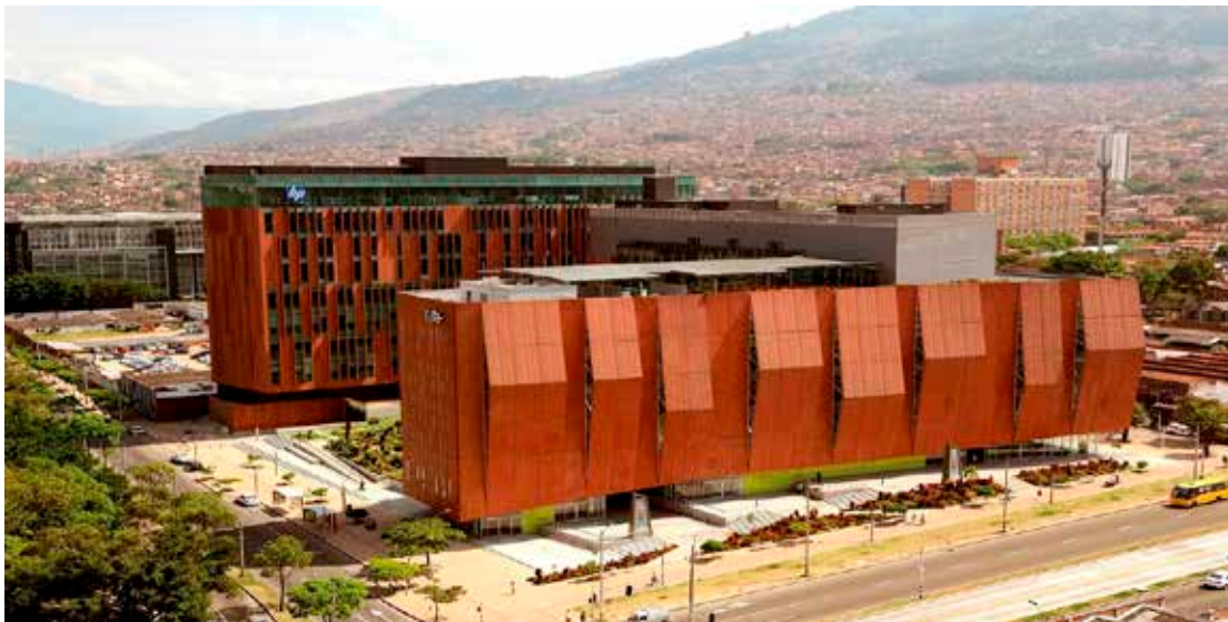
Figura 8. Ruta N, Centro de la Innovación y de Nuevos Negocios. Vista fachadas. Fuente: http://arquitecturapanamericana.com/complejo-ruta-n-centro-de-innovacion-y-tecnologia/ (2011).
