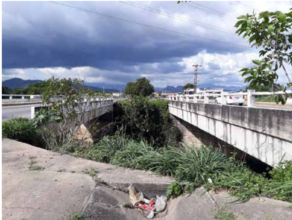
Figura 39: Fotografía del Puente de estudio. Fuente: Pérez, M. (2020)
