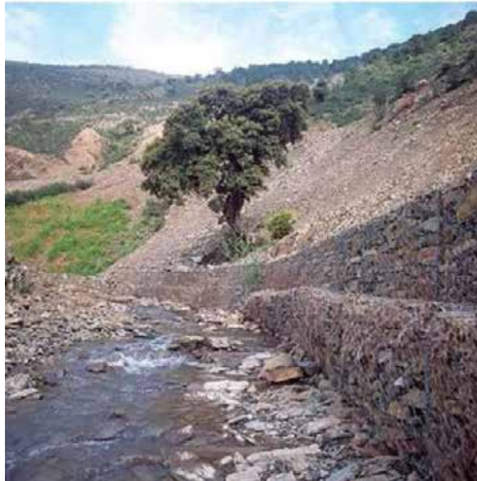
Figura 15: Sistema de muro de gaviones.
