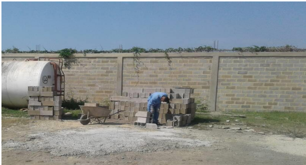
Levantamiento inadecuado y repetitivo de bloques de cemento, representado un riesgo disergonómicos. Fuente: Godoy, C. (2021)
