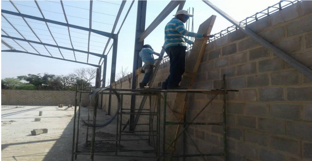
Desarrollo de trabajos en alturas sin los E.P.P adecuados. Fuente: Godoy, C. (2021)
