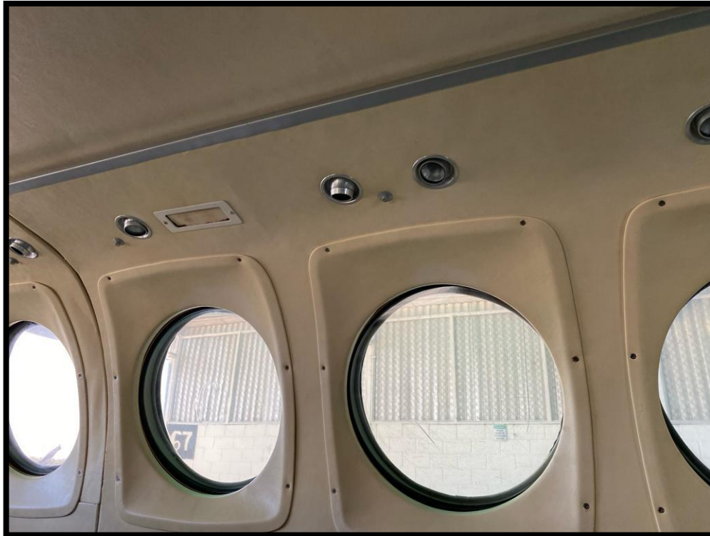
Figura 12. Ductos de salida de aire acondicionado en avión King Air 200. Fuente: Arteaga, W. (2024)
