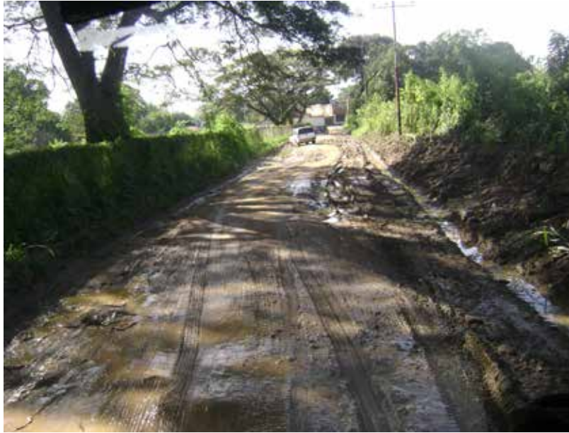
Figura 7. Tramo Carretera La Mariposa.
