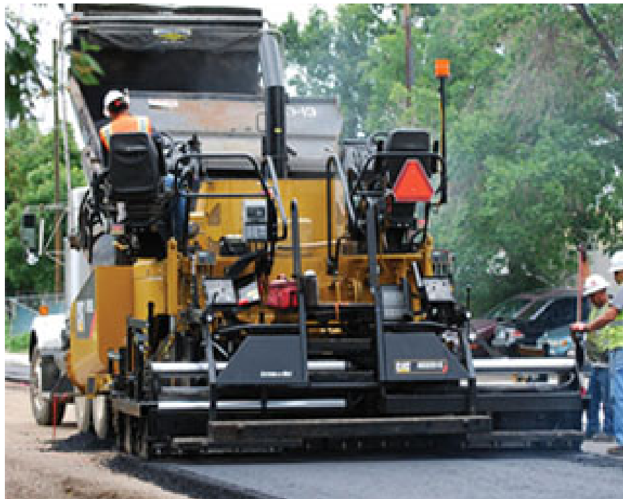
Figura 18: Equipo pesado (Extendedora Finisher).
