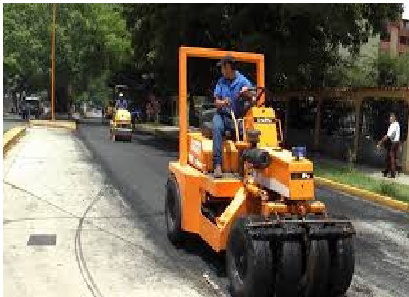
Figura 20: Compactadora neumática de rueda tipo Tampo.
