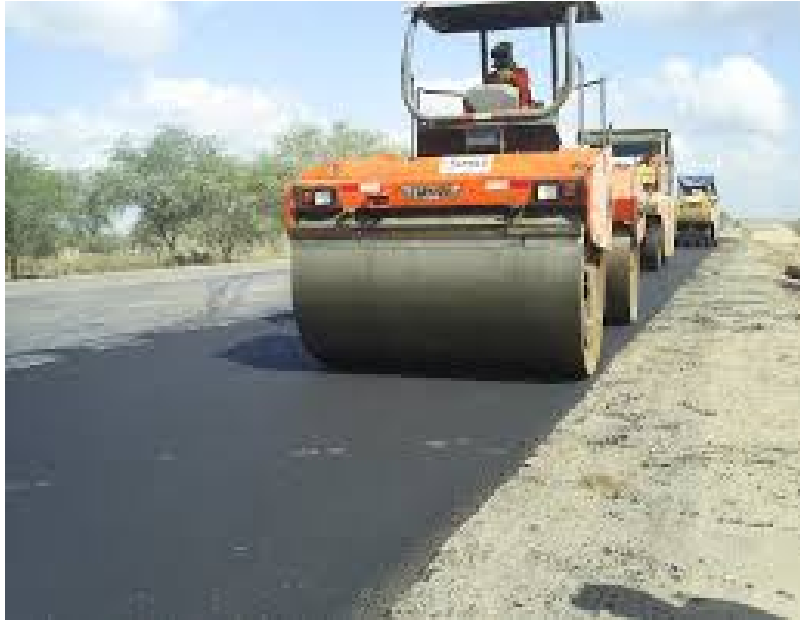
Figura 19: Equipo pesado (Vibrocompactadora).
