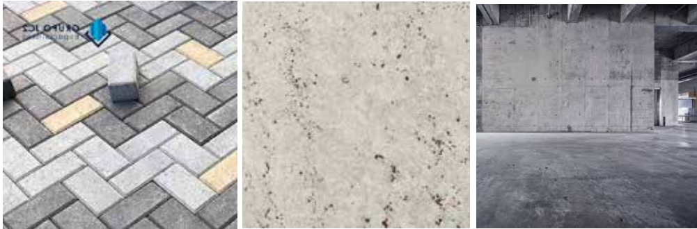
Figura 44. Revestimientos de pisos: adoquines, granito levantina y concreto.
