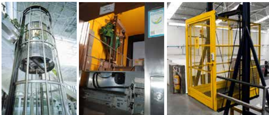
Imagen 51. Elevador panorámico, elevador monospaced y montacargas.
