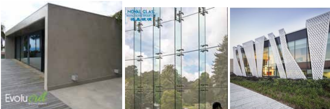
Figura 43. Revestimientos de microcemento, curtain walls y doble piel de acero microperforado en paredes.
