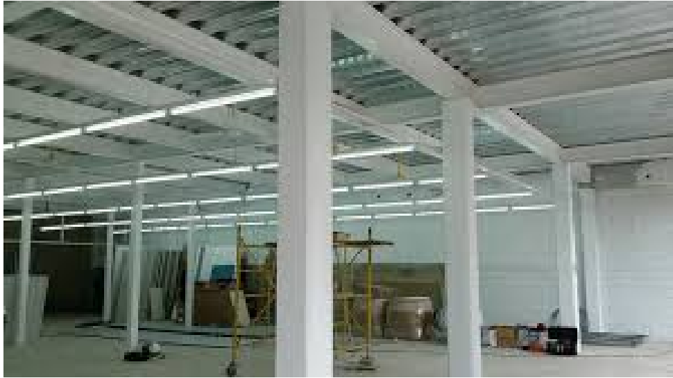
Figura 46. Referencia estructura de concreto y losacero
