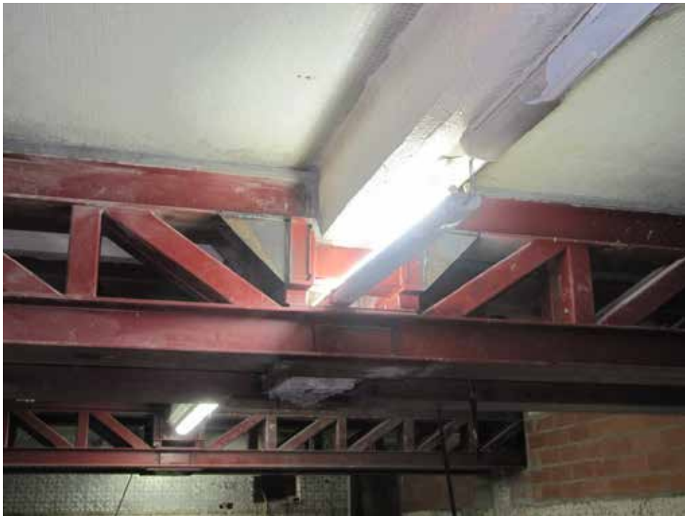
Figura 47. Referencia cercha doble con tubos cuadrados.
