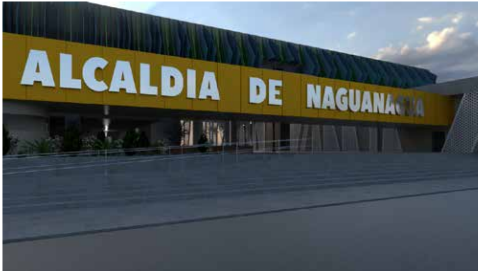
Figura 41. Revestimiento alucobond, letras en acero inoxidable y pérgolas en acero en fachadas
