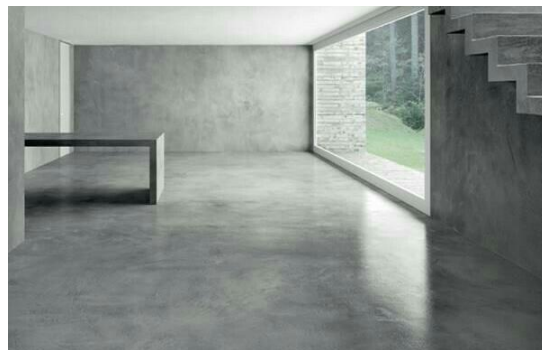
Figura 29. Foto de acabado de microcemento satinado.
