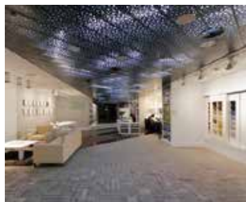
Figura 46. Cielo raso. Fuente: https://www.hunterdouglas.com.co/ap/linea/productos-interiores/cielo-raso-metalico (2017).
