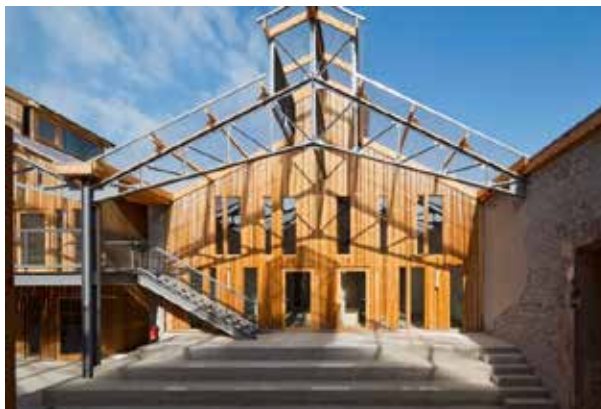
Figura 6. Fachada principal del CCIR. Fuente:
