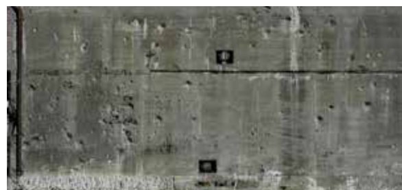
Figura 60. Concreto armado rustico (2017)
