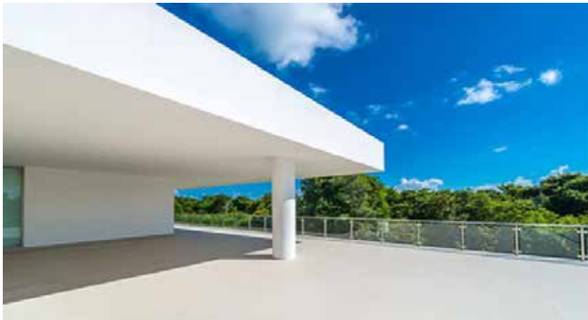
Figura 69. Referencia de acabado con cemento portland blanco en techos exteriores. (2017)
