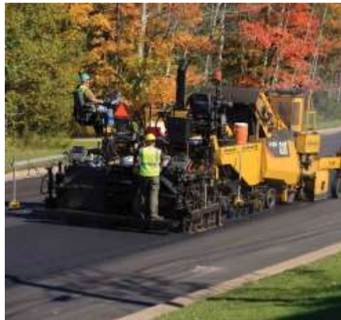
Figura 3: Asfaltadora.
