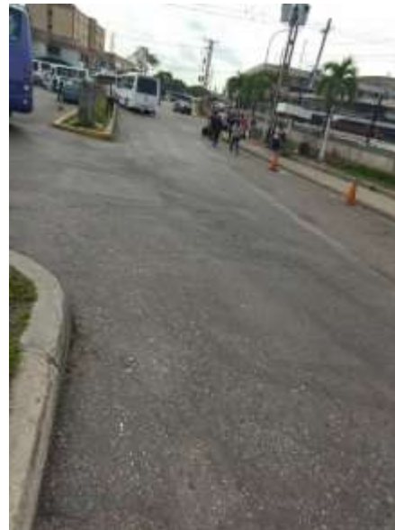
Falla de hundimiento y disgregación en el tramo. Fuente: Iafaioli y Lugo (2022).
