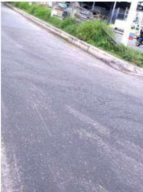
Falla de hundimiento y disgregación en el tramo. Fuente: Iafaioli y Lugo (2022).
