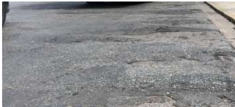
Figura 59: Deformación por empuje
