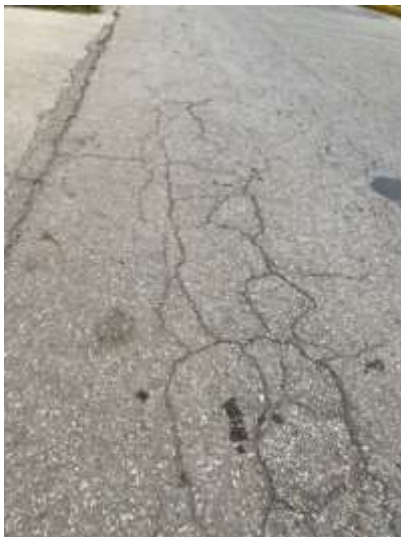
Falla de grietas Longitudinales y baches. Fuente: Iafaioli y Lugo (2022).
