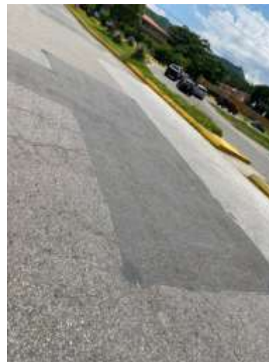
Falla de grietas Longitudinales y baches. Fuente: Iafaioli y Lugo (2022).
