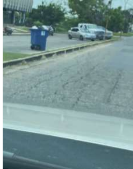
Falla de hundimiento y disgregación en el tramo. Fuente: Iafaioli y Lugo (2022).
