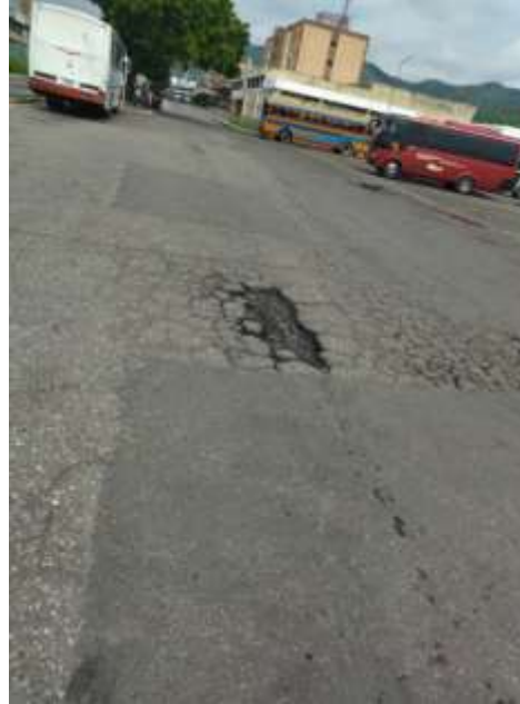
Falla de hueco y piel de cocodrilo en el tramo. Fuente: Iafaioli y Lugo (2022).
