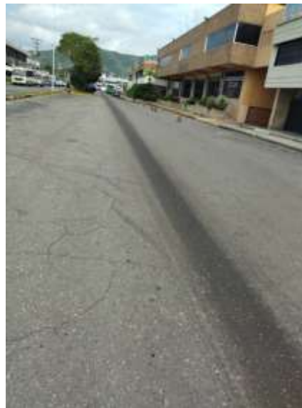
Falla de hueco y piel de cocodrilo en el tramo. Fuente: Iafaioli y Lugo (2022).
