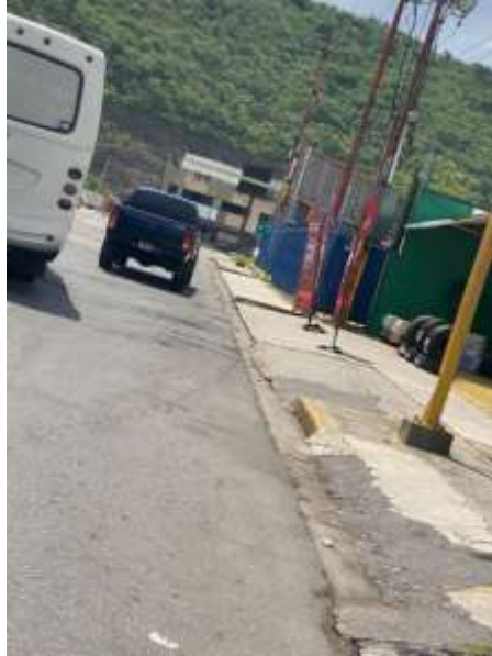
Figura 66. Aceras en el tramo H – G Fuente: Iafaioli y Lugo (2022).
