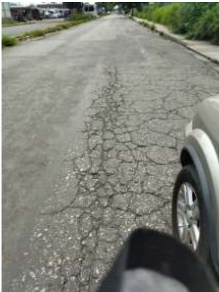
Falla de hueco y piel de cocodrilo en el tramo. Fuente: Iafaioli y Lugo (2022).
