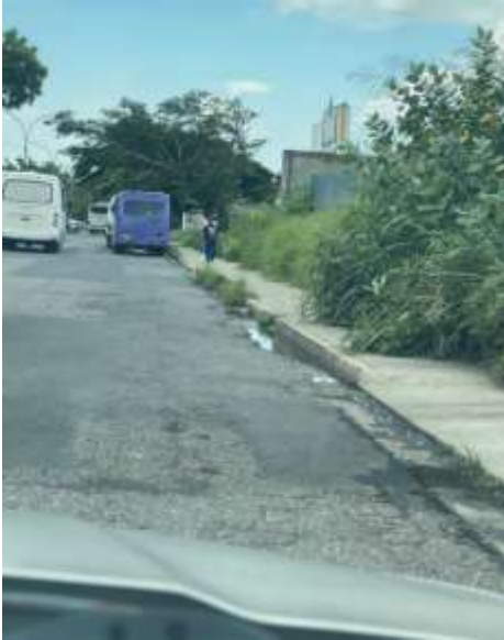
Falla de hundimiento y disgregación en el tramo. Fuente: Iafaioli y Lugo (2022).
