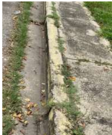
Figura 63. Aceras en el tramo D – B
