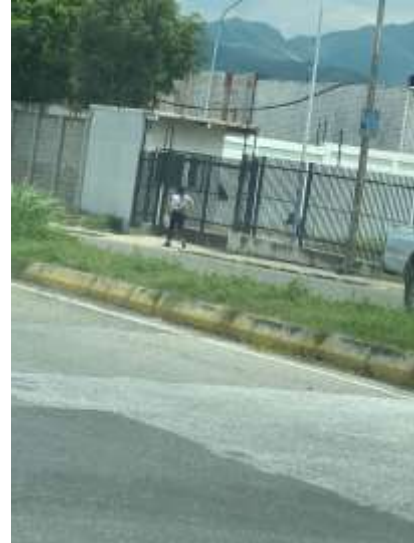
Falla de demarcación y de borde Fuente: Iafaioli y Lugo (2022).
