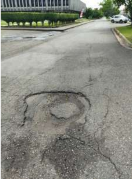
Falla de hueco y piel de cocodrilo en el tramo. Fuente: Iafaioli y Lugo (2022).
