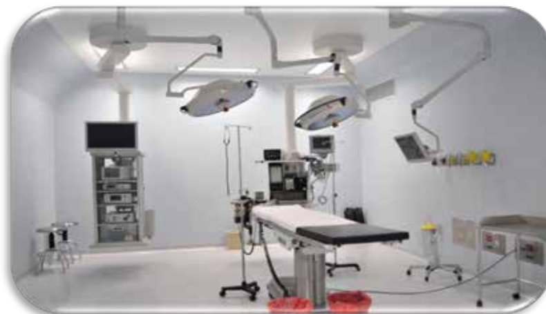
Figura 19. Acabado en quirófanos
