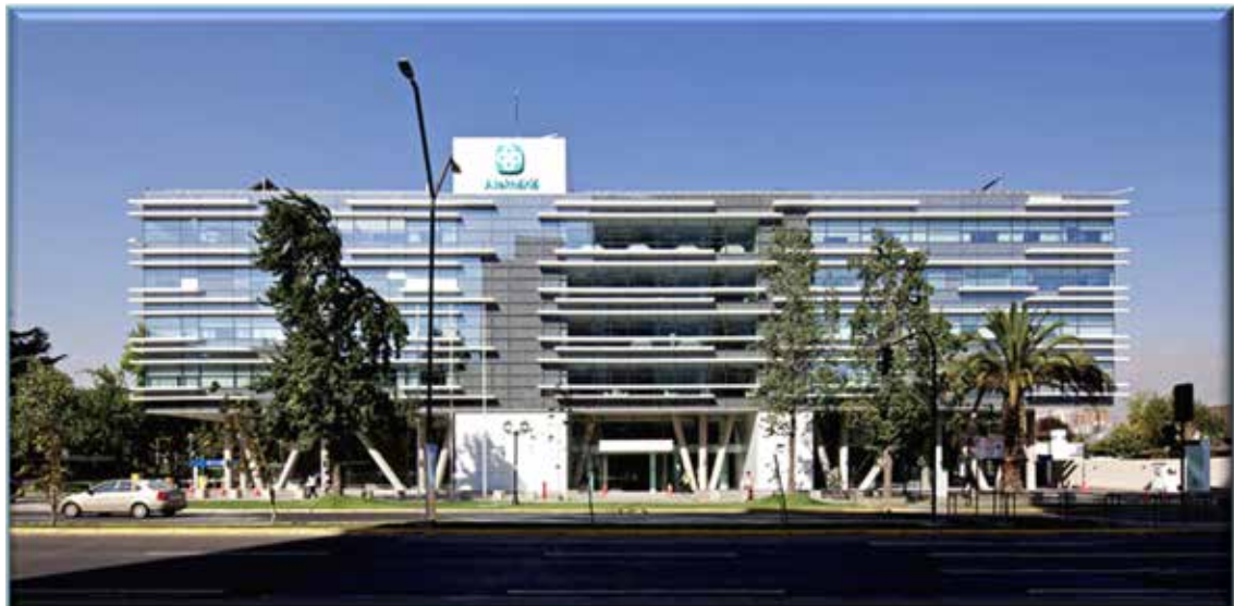
Figura 9. Fachada del Centro Clínico Manquehue (2012)
