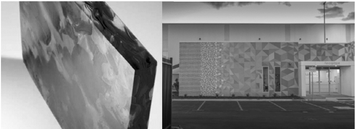
Figura 26 . Fachada recubierta con panel de vidrio reciclado, Fuente:
