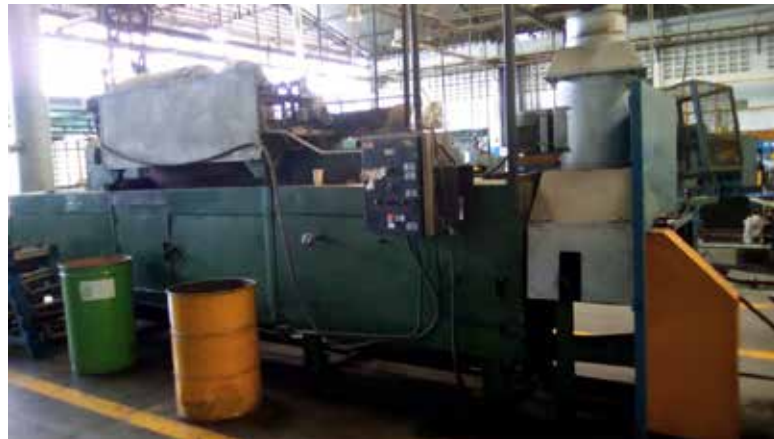
Figura 4. Sistema de hornos línea de elementos 2
