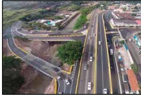
Figura 46: Distribuidor Puente Real
