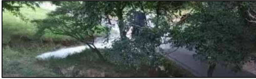
Figura 47: Fuga de agua debido a la falta de Mantenimiento en el Distribuidor de Palmira
