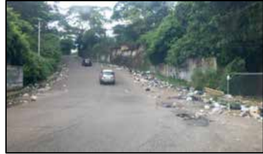
Figura 53: Situación de Desechos Sólidos, embaulamiento de la quebrada La Arenosa
