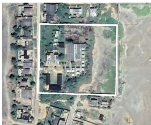
Figura 1. Foto satélite del terreno
