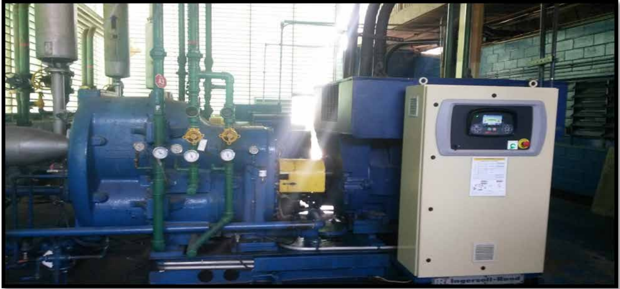
Figura 30. Compresor N o 1 Ingersoll – Rand, modelo Centac – C30
