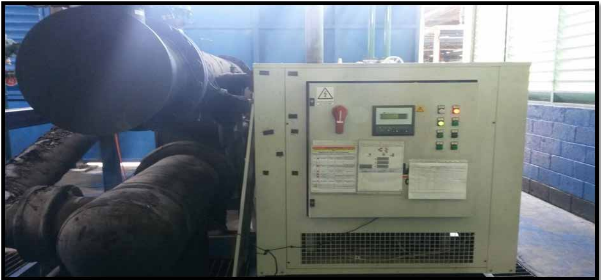
Figura 33. Secador Motivair, modelo CWD – 8000
