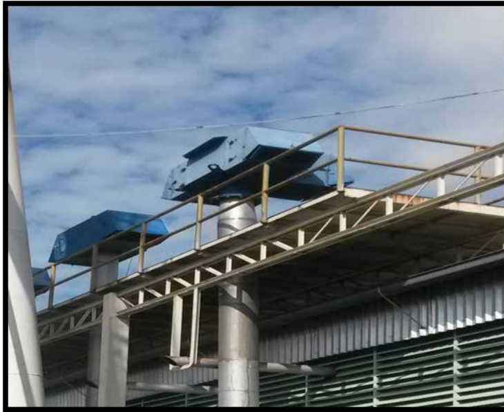
Figura 36. Filtro de admisión del compresor Centac – C30.
