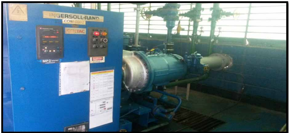
Figura 31. Compresor N o 2 Ingersoll – Rand, modelo Centac – C26
