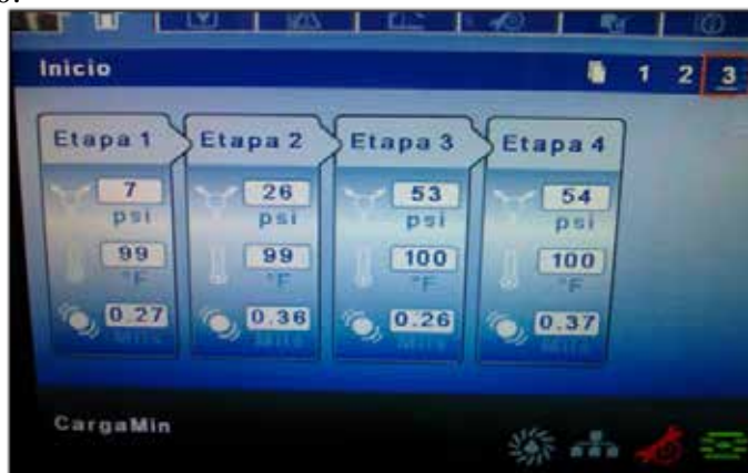
Figura 27. Valores sobre el funcionamiento que muestra el sistema de monitoreo del compresor Centac – C30.
