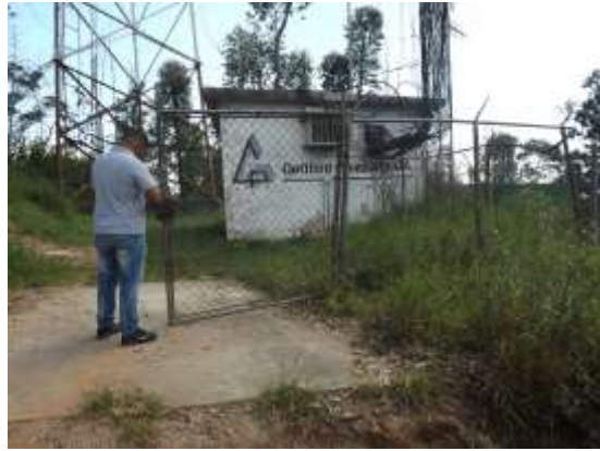
Figura 4. Llegada a la caseta
