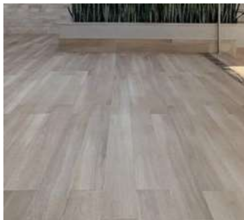
Figura 35. Piso de vinilo con un revestimiento plástico fabricado de PVC (Policloruro de vinilo) Fuente: La Autora (2022).
