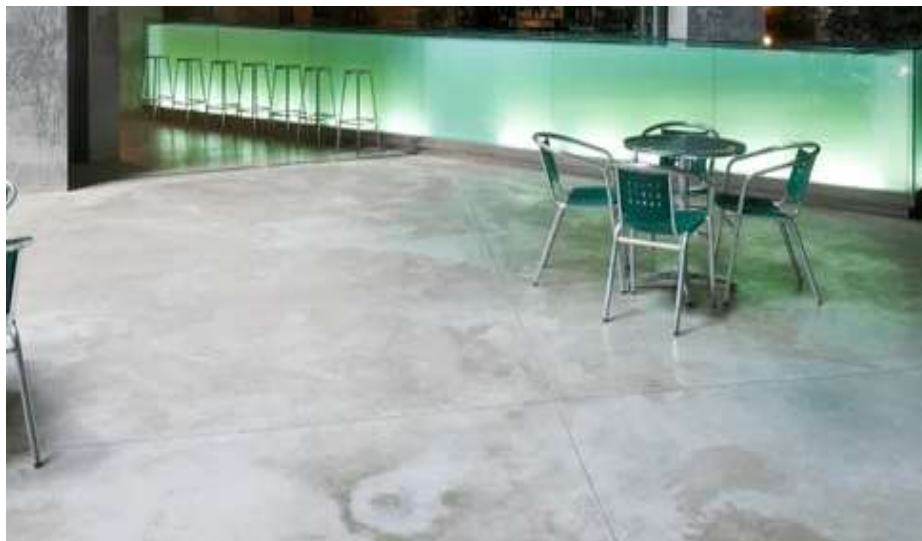
Figura 37. Piso de Hormigón Pulido Fuente: La Autora (2022).
