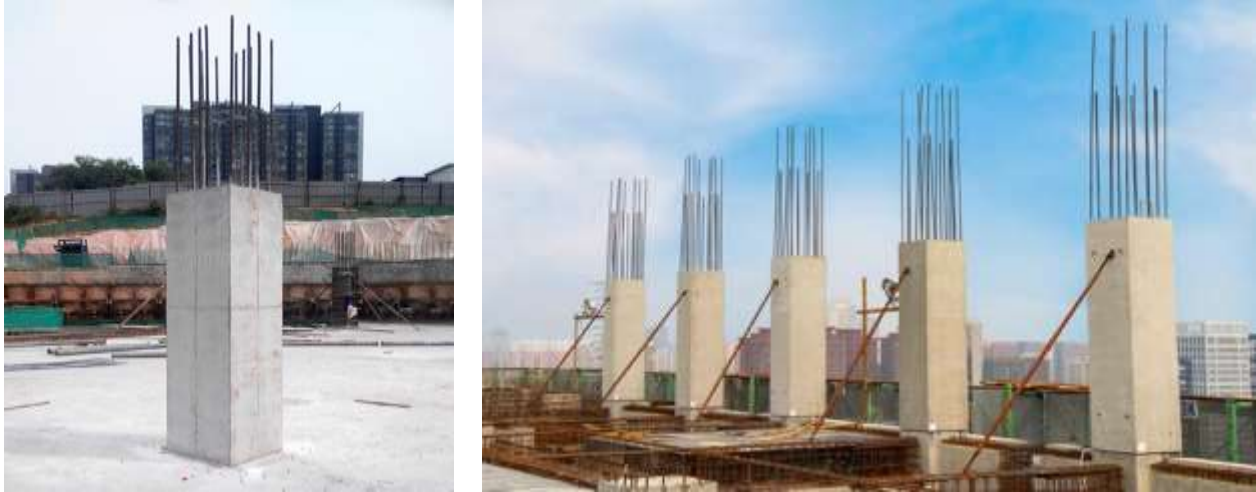
Figura 49. Columna de concreto Fuente: El Autor (2023)
