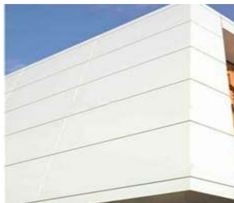
Figura 33. Paredes Externas con Alucobond Fuente: La Autora (2022).
