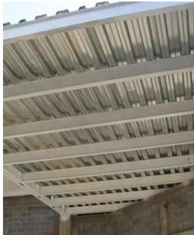
Figura 48. Losa de Entrecimpo losacero Fuente: El Autor (2023)
