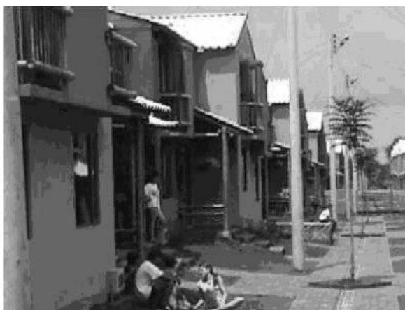
Figura 2: Casa Económica ya terminada.
