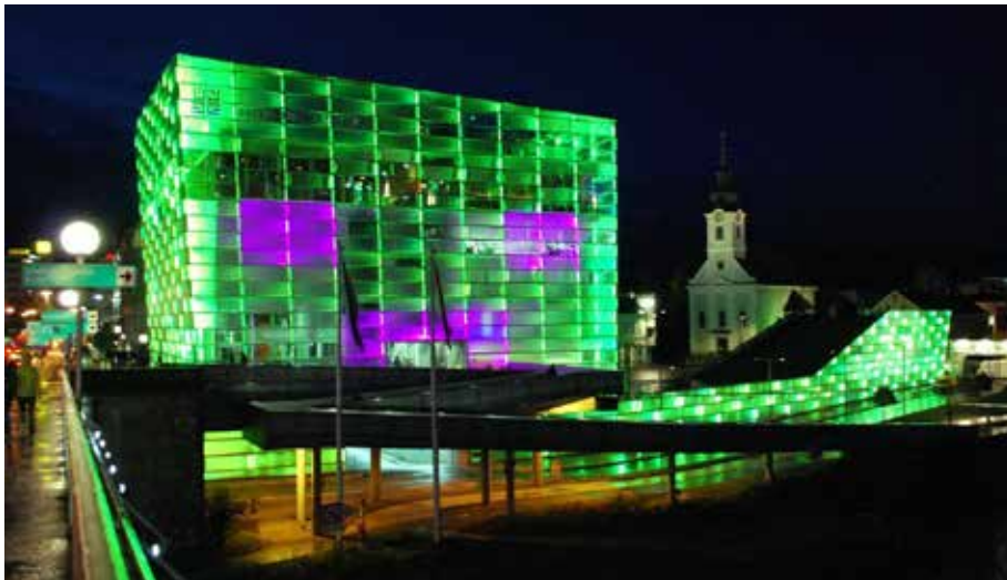
Figura 16: Sistema de luces led en fachada
