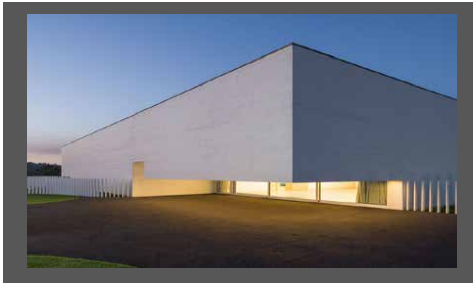
Figura3: Escuela Infantil Casa de Magalhães / Carvalho Araújo Fuente: Plataforma Arquitectura (2010)
