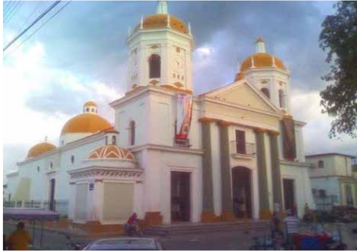
Figura 6: iglesia Naguanagua casco histórico. Fuente: google (2016).
