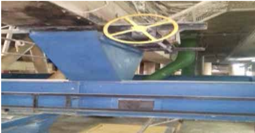
Figura 15. Zona 3, Compuerta Transportador 78 que conecta al transportador 7815, ubicada en el piso 6
