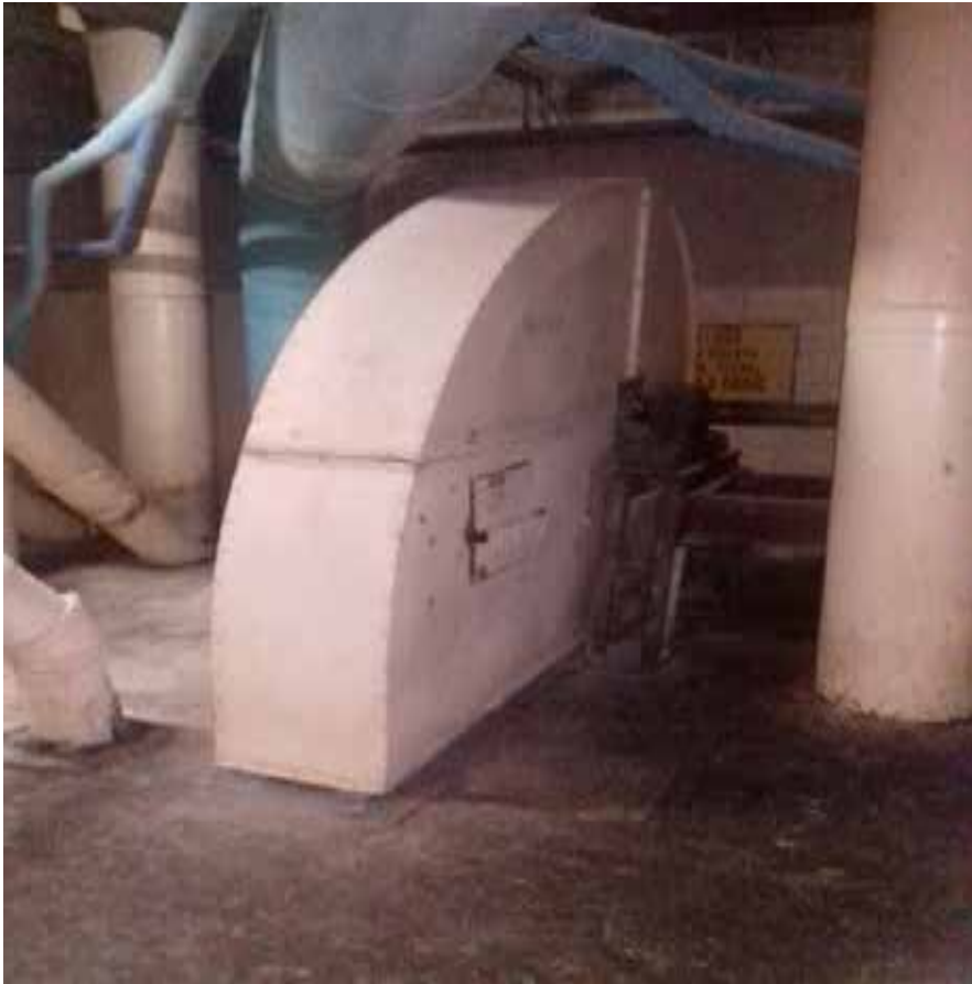
Figura 11. Zona 3, cabezal del elevador 7 , ubicada en el piso 8
