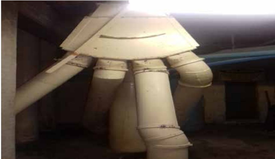
Figura 12. Zona 3, Distribuidor del elevador 7 , ubicada en el piso 7
