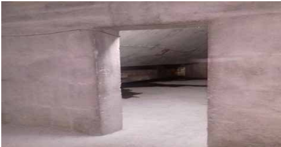
Figura 8. Zona 2 Cuarto de compuertas silo 3. IV grupo , ubicada en el sotano
